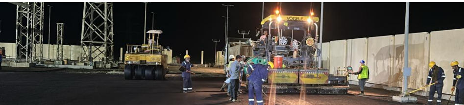
أعمال الأسفلت Asphalt Work
